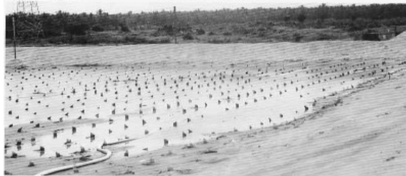
Pemasangan Colbond-drain pada interval yang rapat akan mempercepat proses kompaksi air pori di dalam tanah akibat.
