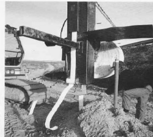
Selanjutnya dipasang drain yang penting sekali.
