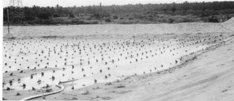
Pemasangan Geobond drain pada interval yang rapat akan mempercepat proses pemampatan dan penarikan air dari tanah lunak.
