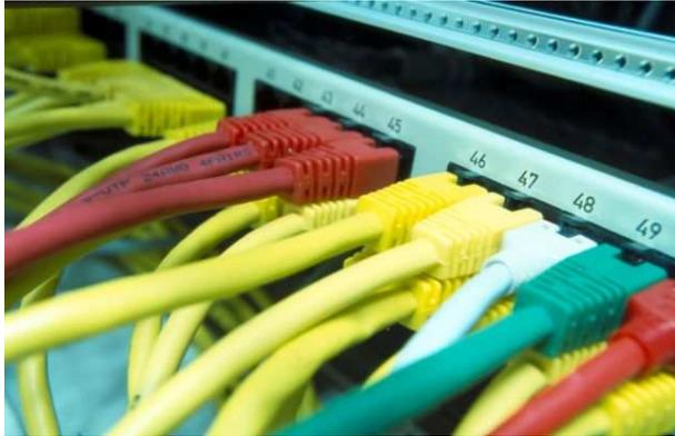
Bagian depan patch panel terlihat seperti kumpulan RJ-45 biasa, tetapi di bagian belakang terdapat port untuk menghubungkan RJ-45 yang telah tersambung dengan kabel. Pada prinsipnya, patch panel adalah komponen yang akan disatukan penggunaannya dengan patch cord.
